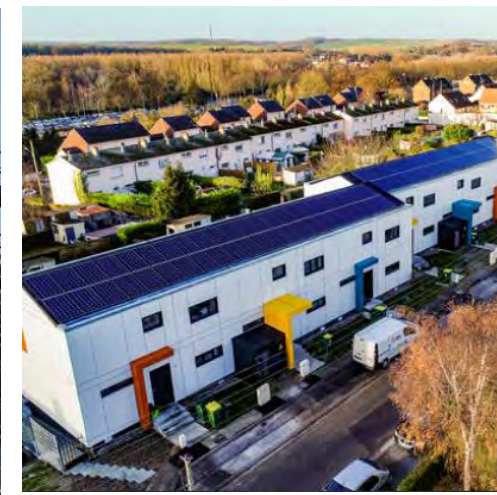
12 logements EnergieSprong Longueau / ICF
