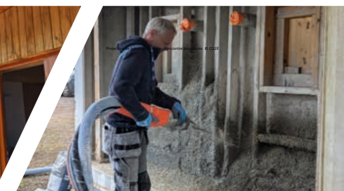
Projection de béton de Chanvre © SC2NE
